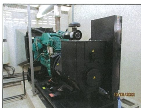
ภาพถ่ายที่ 1.6.4-1 เครื่องกำเนิดไฟฟ้าสำรอง
