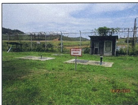
ระบบบำบัดน้ำเสียแบบเติมอากาศบริเวณอาคารผู้โดยสาร
